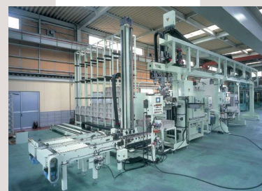
[平成13年] 24H、ストッカー付ローダーシステム
